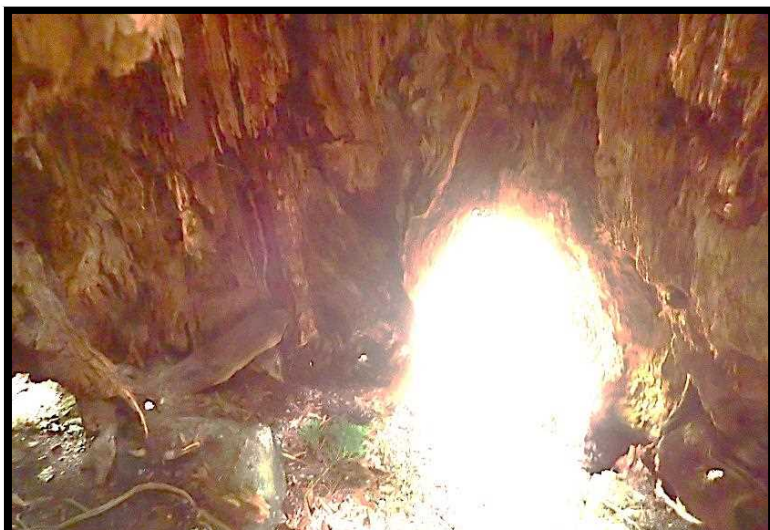
内部の腐朽状況(スポンジ状)
