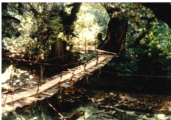
昭和 56 年淀川橋
