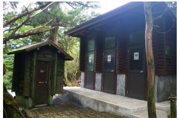
新高塚汲み取り式トイレと土壌処理式トイレ
