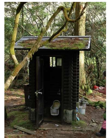
淀川小屋汲み取り式トイレ
