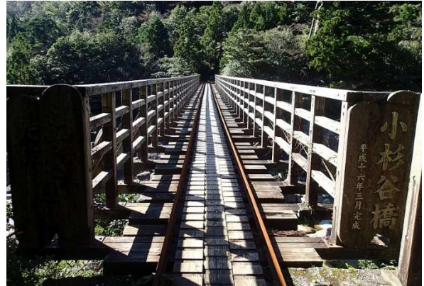
橋脚、橋梁部分の所有者が不在の小杉谷橋
