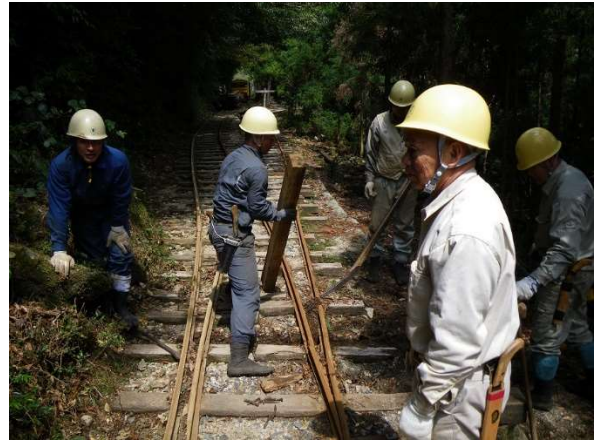
土埋木搬出が行われていた頃の軌道の補修(2009年)
