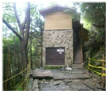
大株歩道トイレ
