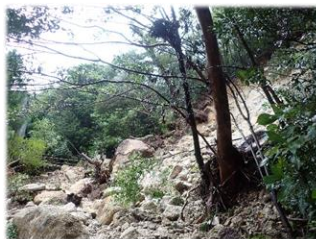
さつき吊橋付近大規模崩落
