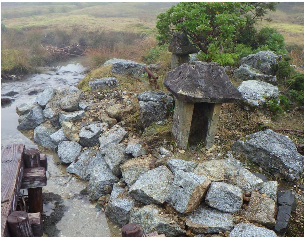
写真4 祠土台部分の石積み（設置後）
