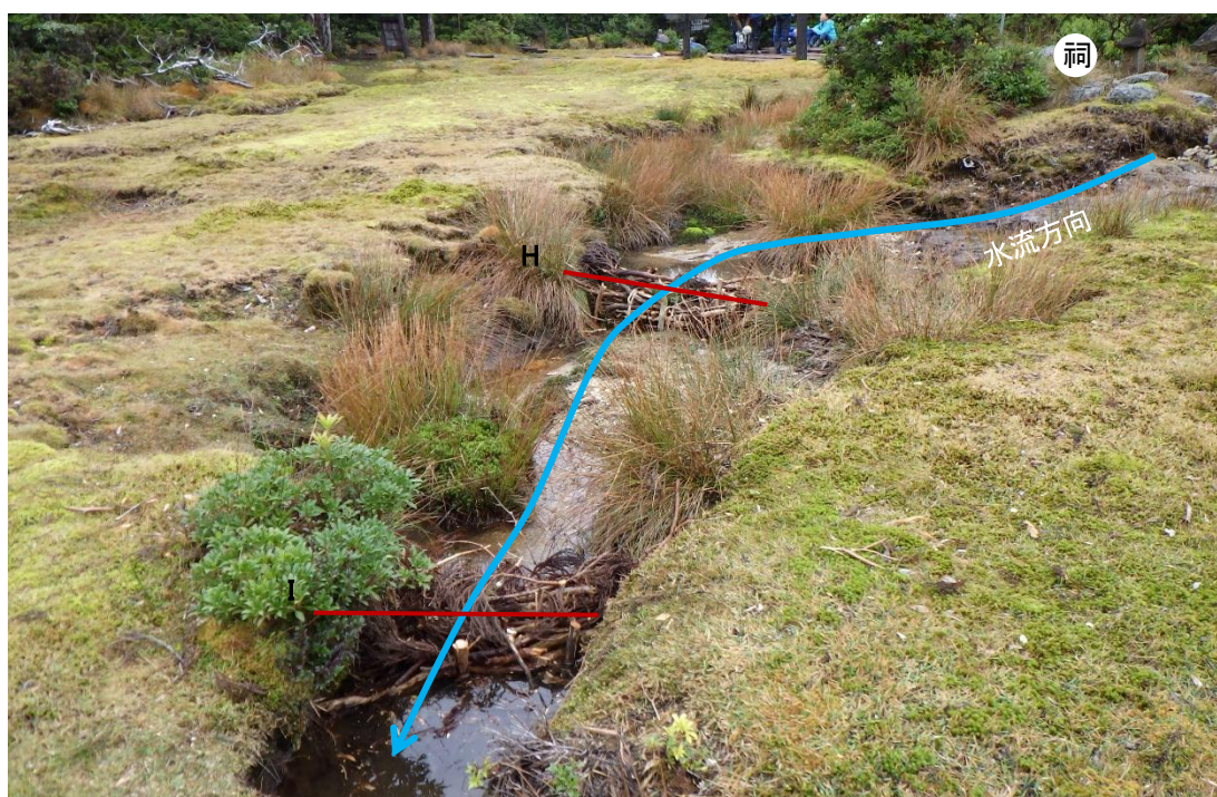
写真1 堰 H,I 設置直後(2024/11/20 撮影)
