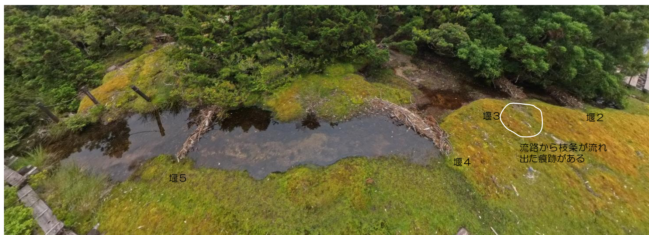
写真1 堰1～5の設置から約6カ月経過（2025/7/9 撮影）
