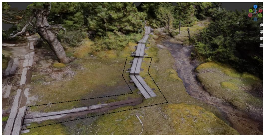
図1 床板の撤去前
