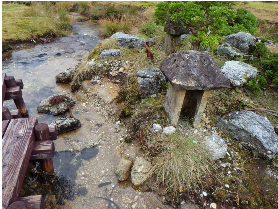
写真4 祠土台部分の石積み（設置前）
