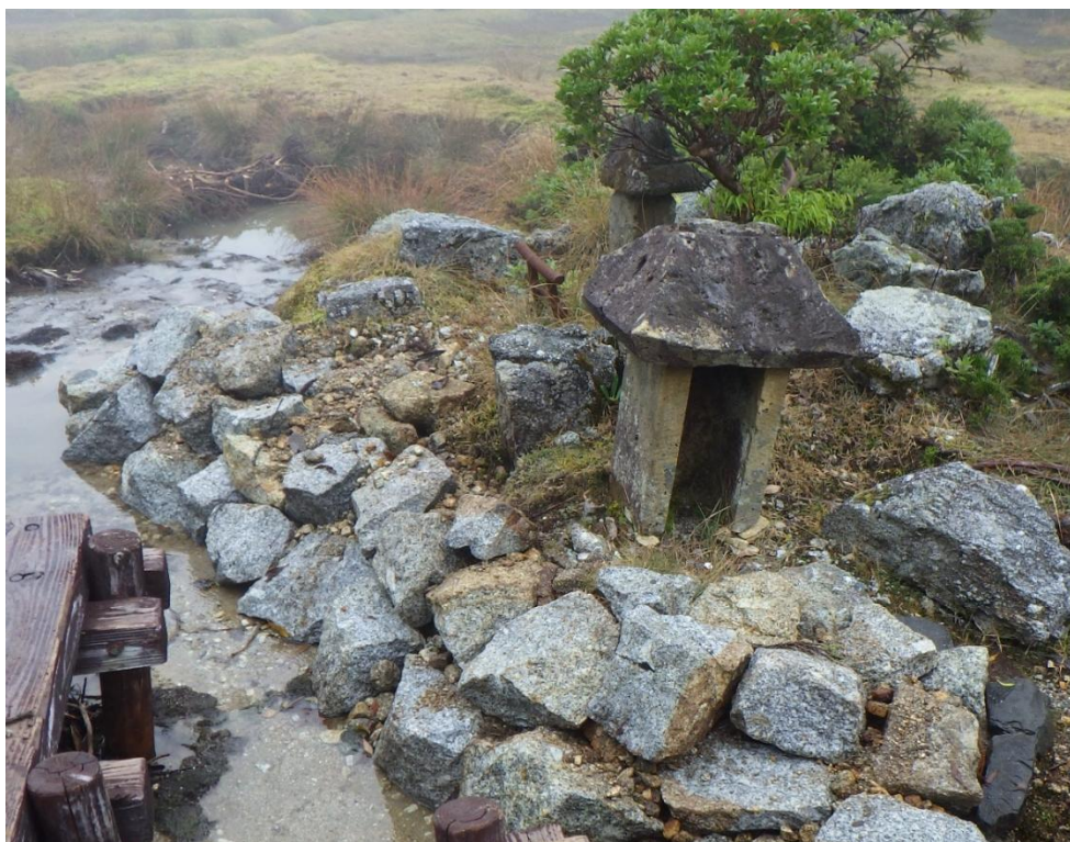
写真5 祠土台部分の石積み（設置後）
