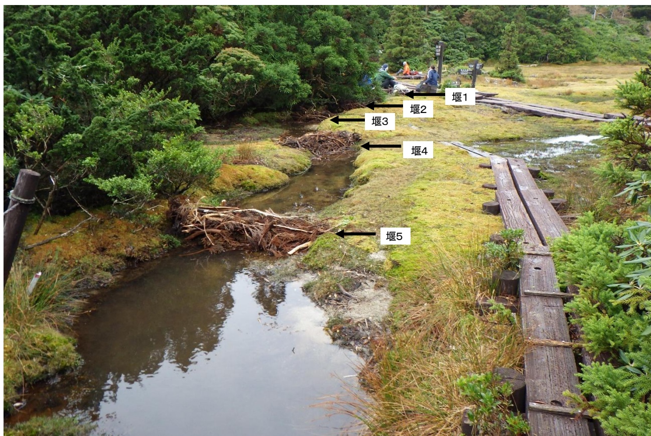
写真2 東側流路の流水分散対策 (R6. 11. 20 堰を5か所設置)
