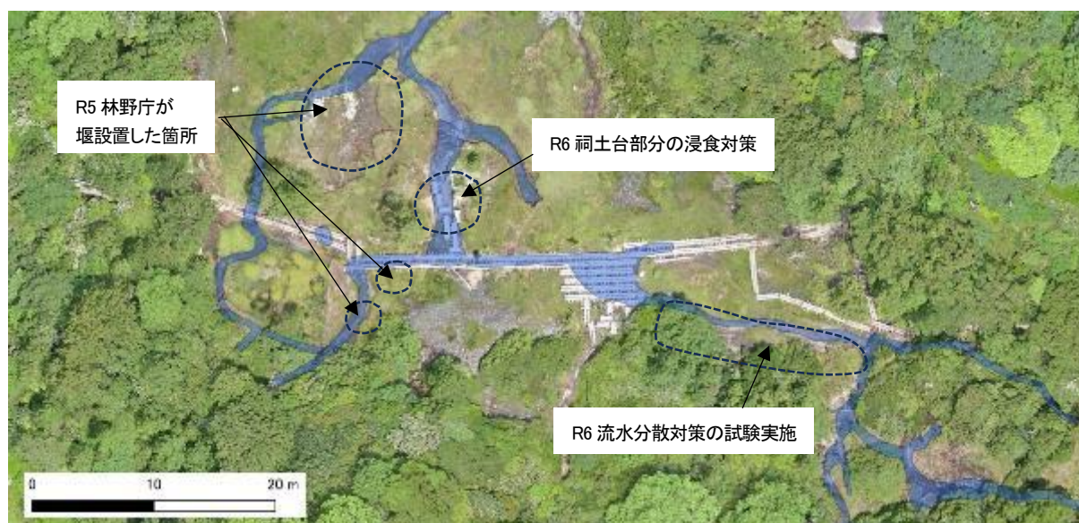
図1 R5 林野庁の対策箇所、R6 環境省の対策箇所
