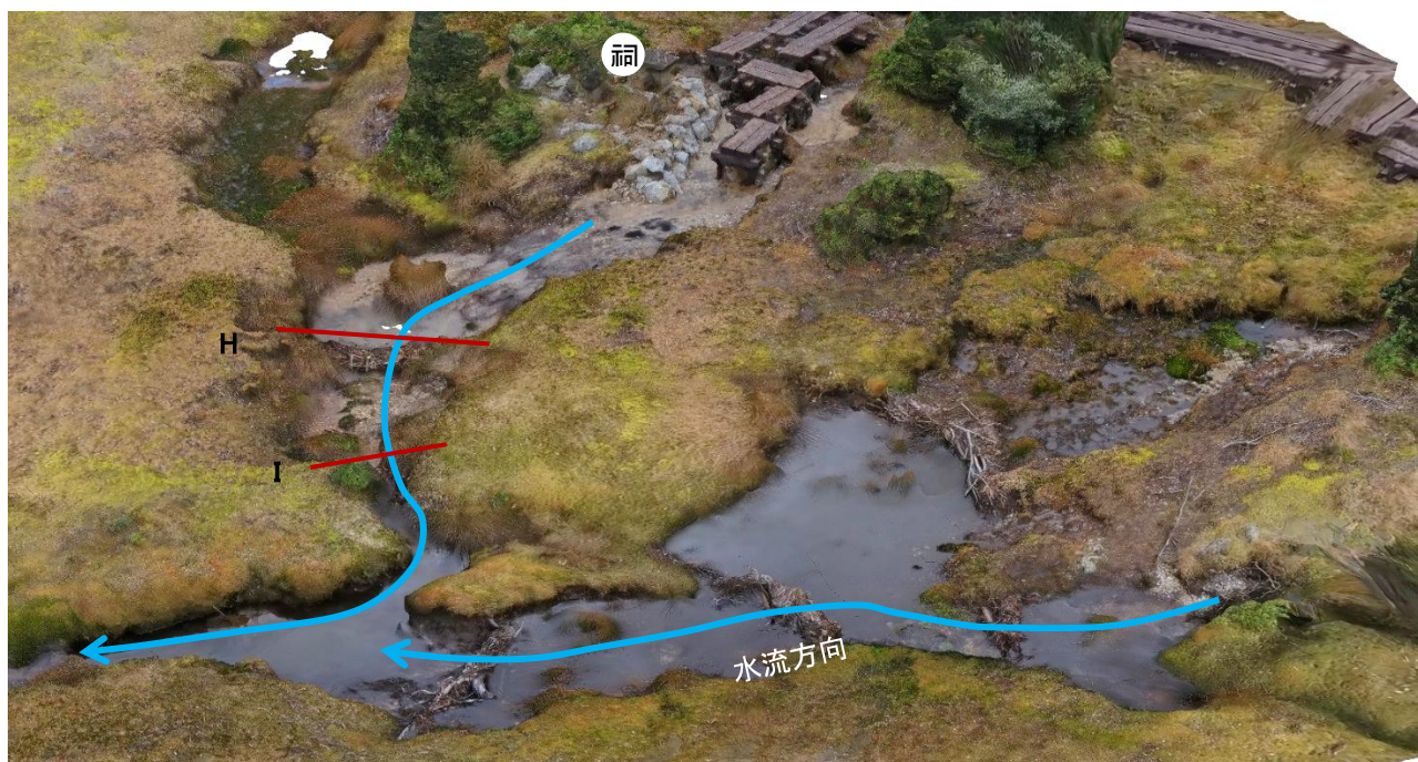
写真5 令和6年度の堰設置箇所(2箇所)
