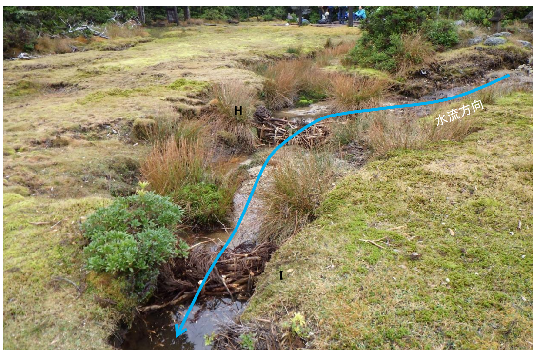
写真6 堰 H,I 設置直後(2024/11/20 撮影)
