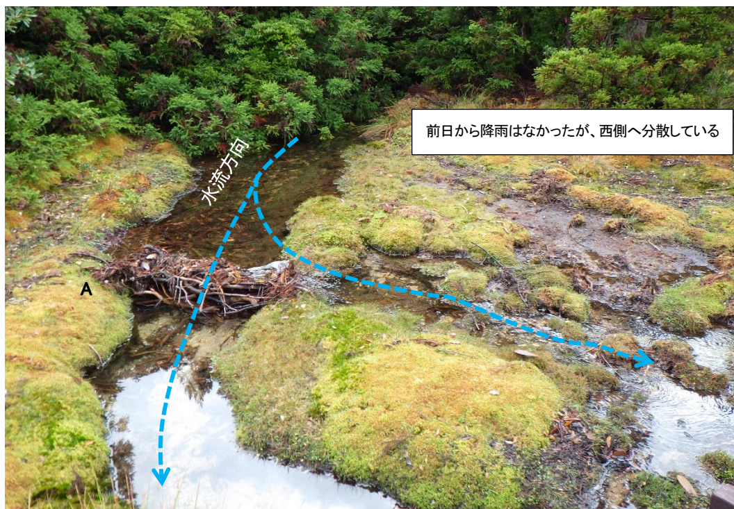
写真3 堰 A の設置から約 11 か月経過(2024/10/27 撮影)
