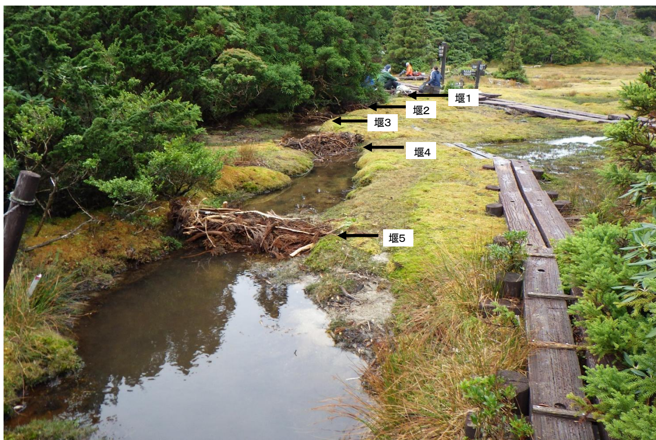
写真2 東側流路の流水分散対策（堰を5か所設置）
