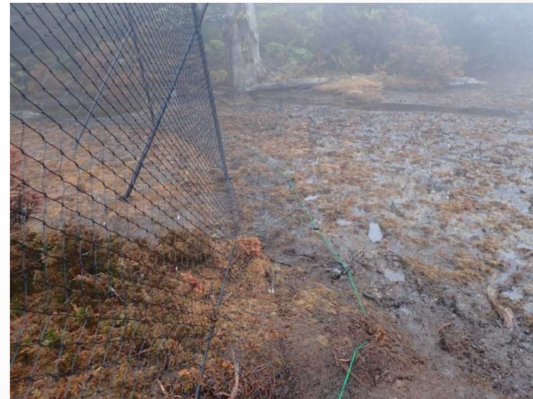
ネット張替え後
