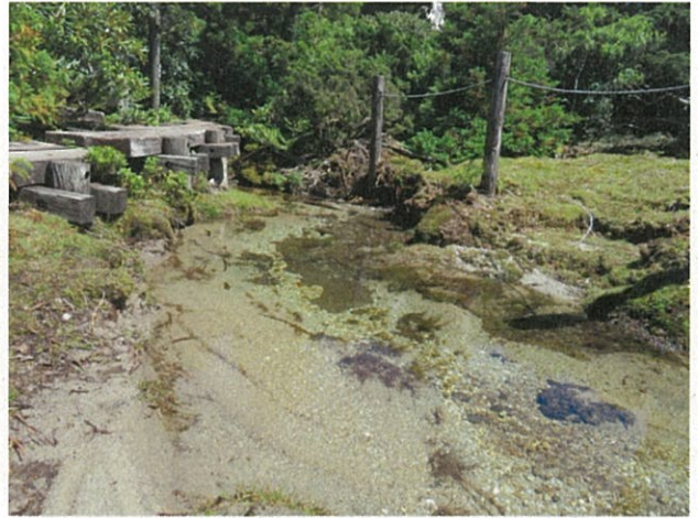
⑭流路からの土砂の流入状況
