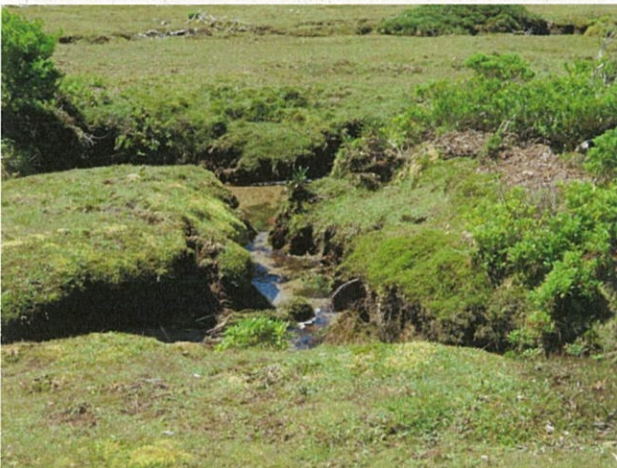
⑨縦浸食の状況
