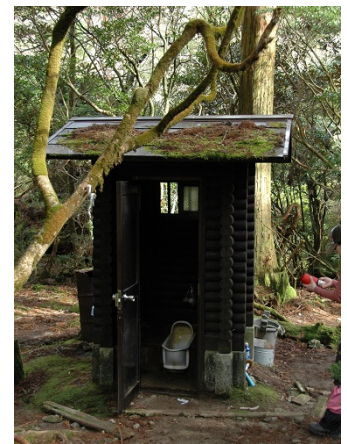
淀川小屋汲み取り式トイレ
