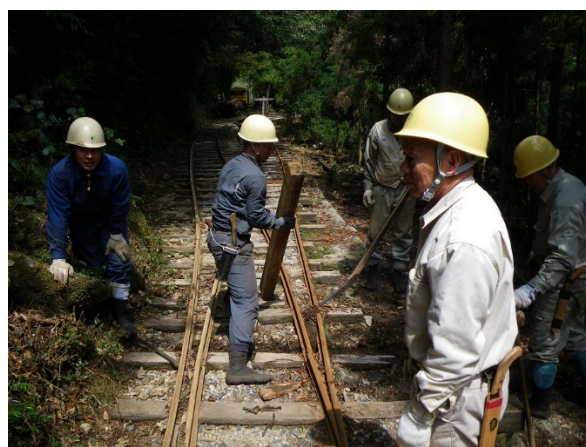
土埋木搬出が行われていた頃の軌道の補修（2009年）
