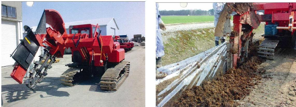
写真 II. 6. 7 塩ビシート埋設機器参考事例
