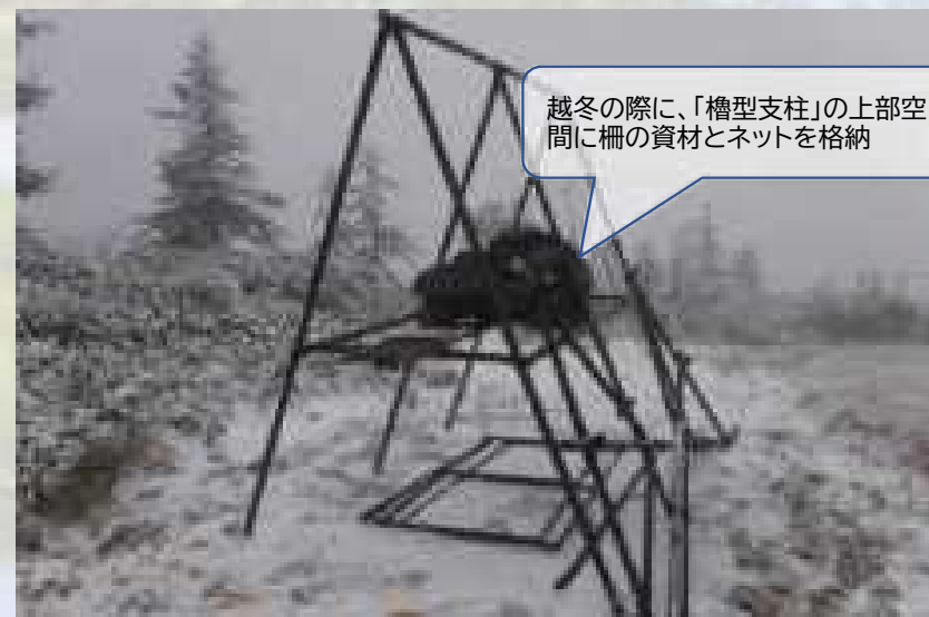
櫓型支柱の越冬前の様子
