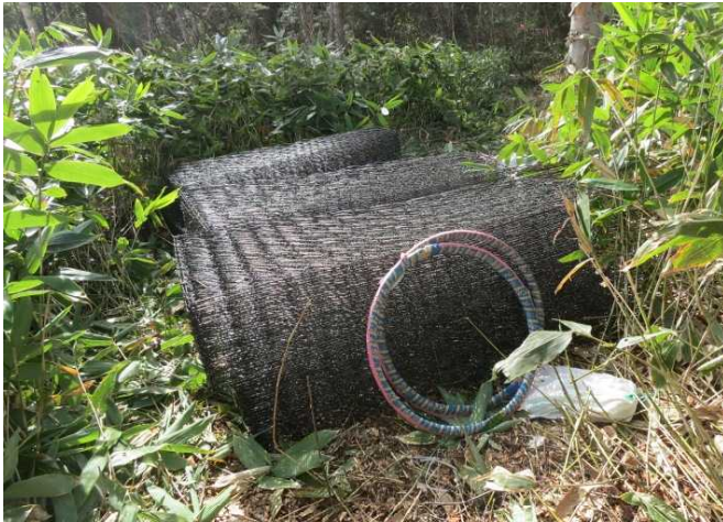
資材は周囲20箇所分散配置(笹生地)
