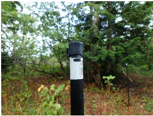
試験柵 A 支柱上部品の破損
