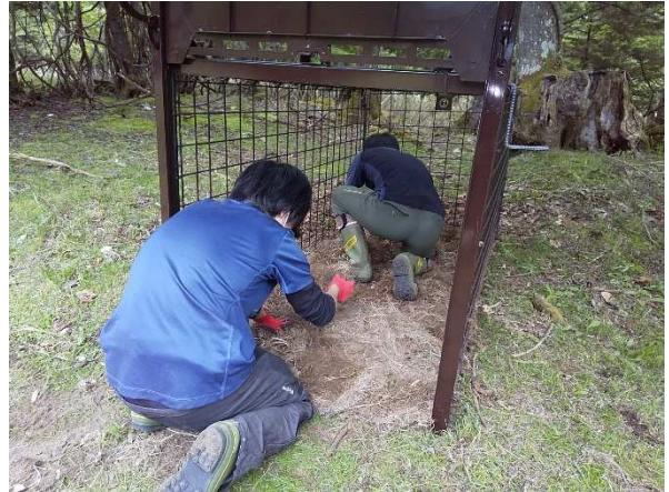
写真 3-2-3-15 箱わな底面部の埋設
