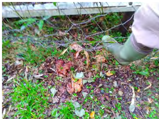
写真 4-1-4-8 ペグがなくシカが潜れる箇所
