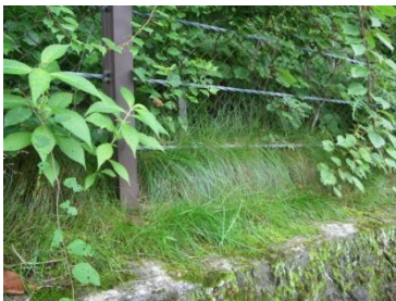
上部ゾーン 平成 25 年 7 月 31 日
