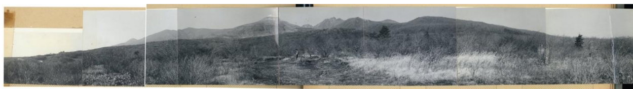
写真Ⅱ-2-3 県道那須甲子線新築の景観写真(1968 年 11 月 8 日撮影)
