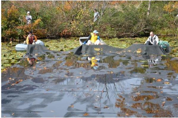
シート先端中央にアルミポートを加えて、ポート上からシートを持ち上げて敷設している状況
