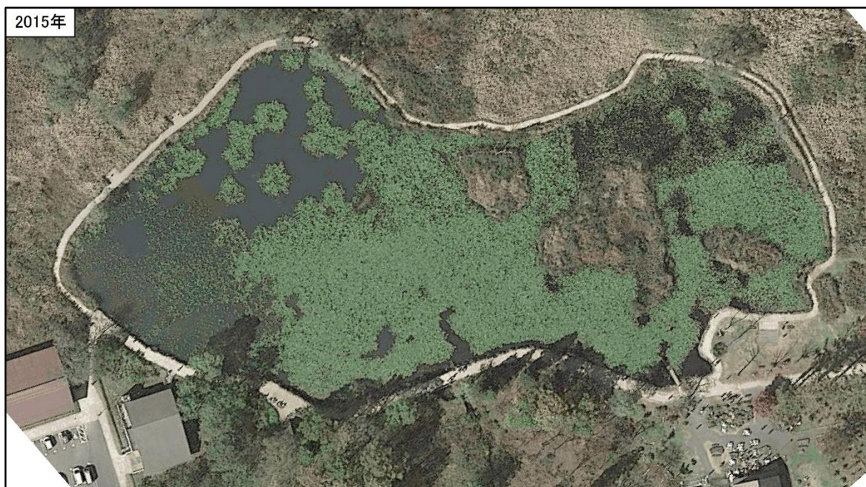
写真 II-21 2015 年(平成 27 年)10 月 27 日 Google 写真
