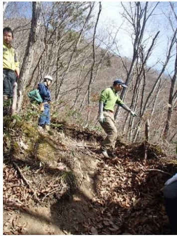
作業前（深い浸食がみられる）
