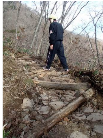
作業後（水の流れを考えながら、 浸食箇所を周囲の倒木や土石で埋めて施工）
