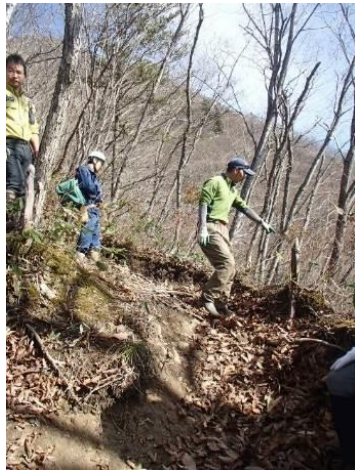
作業前（深い浸食がみられる）
