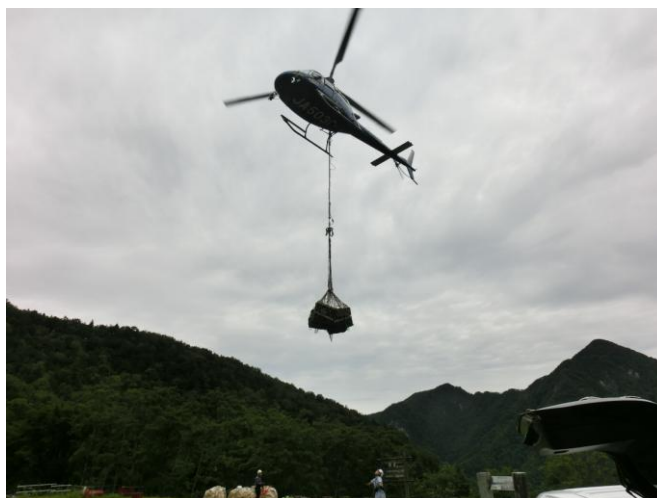
写真16 歌宿での搬出資材の受け取り
