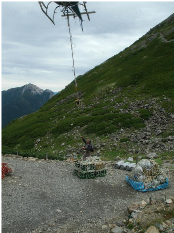
写真15 仙丈小屋からの資材の搬出
