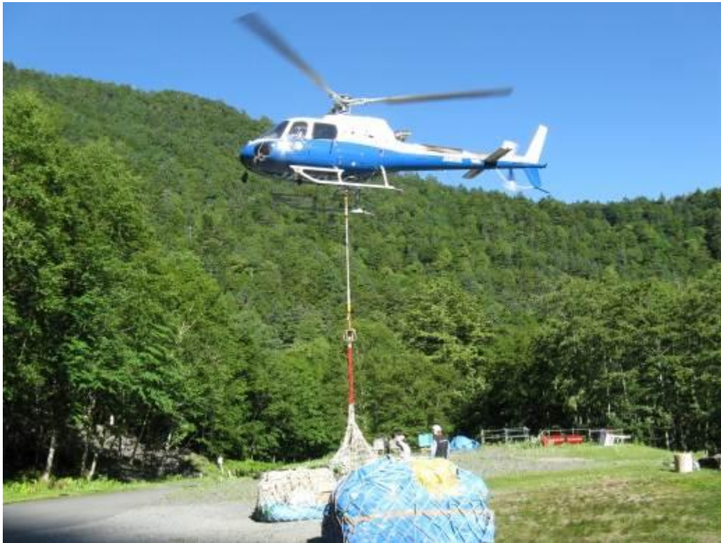
写真 16 歌宿からの資材の搬出
