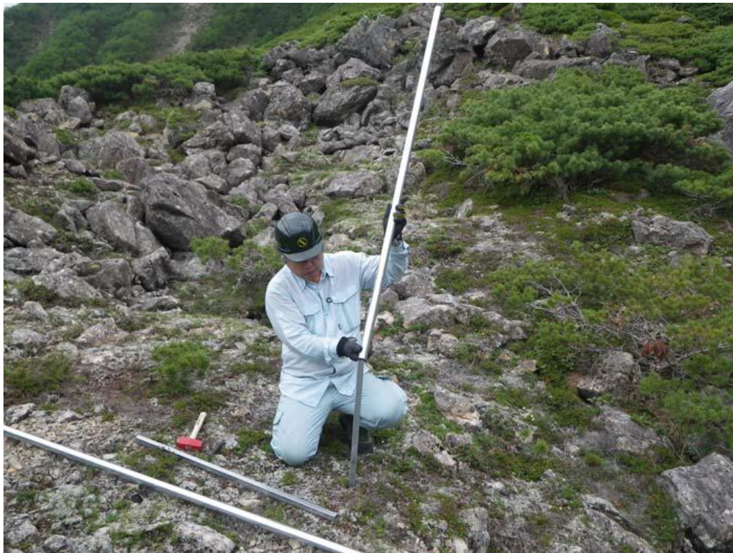
写真 21 誘導柵の設置①
