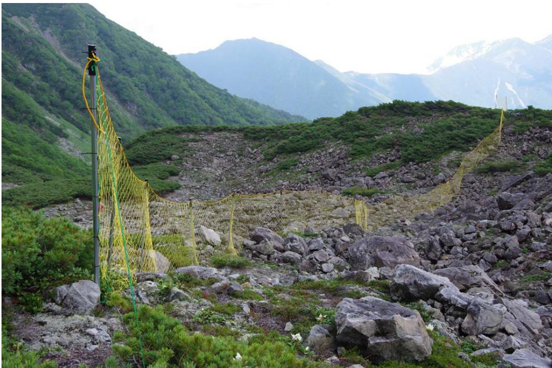
写真 24 誘導柵の設置④
