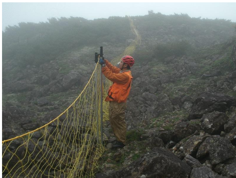
写真 51 誘導柵の撤収作業
