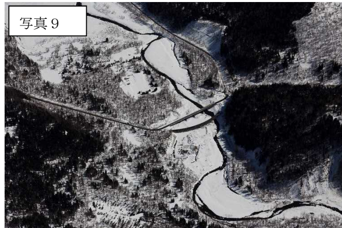
国道273号高原大橋付近
