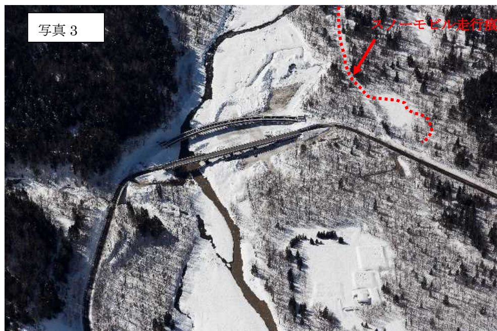
国道 2 7 3 号高原大橋付近
