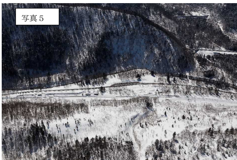
国道273号線駐車帯（中越トンネル上川側出口付近）
