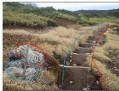
回収したロープは左右で長さの違うため、分けて置いてある。赤い帯で囲んであるロープは、総合分岐方向を見て右側、青い帯で囲んであるロープは、左側のロープである。
