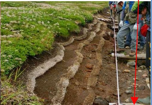
7月初旬の豪雨により大きく崩壊した間宮城周辺。距離40mほどが侵食されており、場所によっては1.5mほどの陥没状態になっている。
