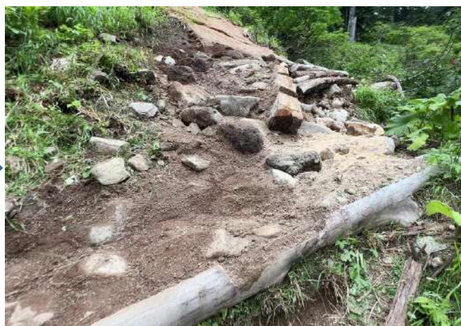
木柵階段5段、石段10段の補修
