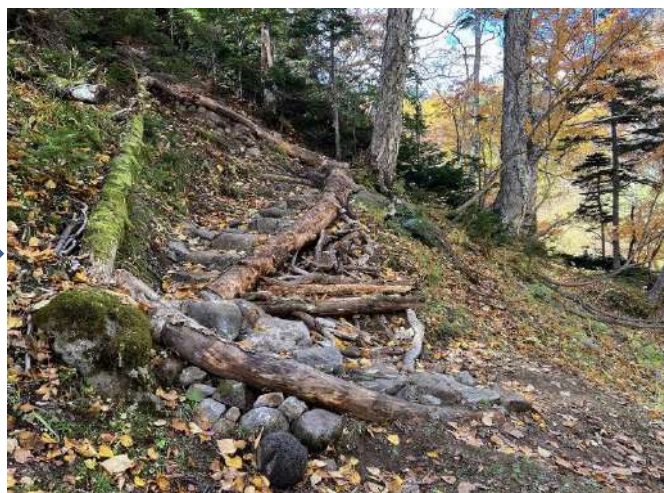
木柵及び石材にて32段の階段設置
