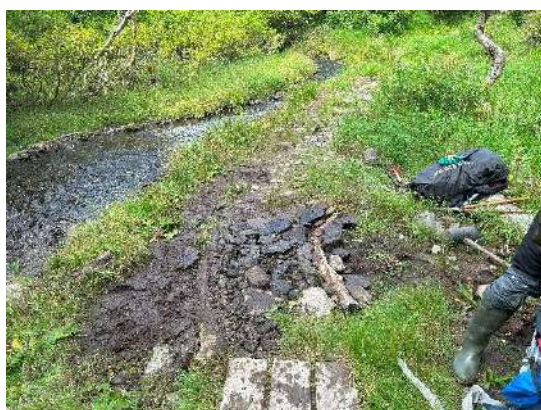
泥濘箇所に石材を充填して歩行路を設置
