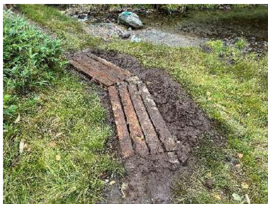
泥濘箇所に石材を充填して歩行路を設置
