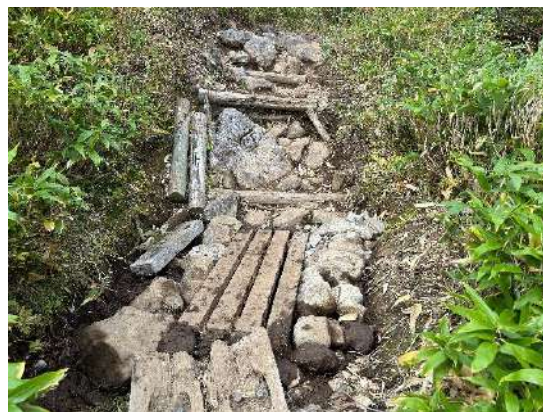
堆積した砂利の除去と飛び石の設置
