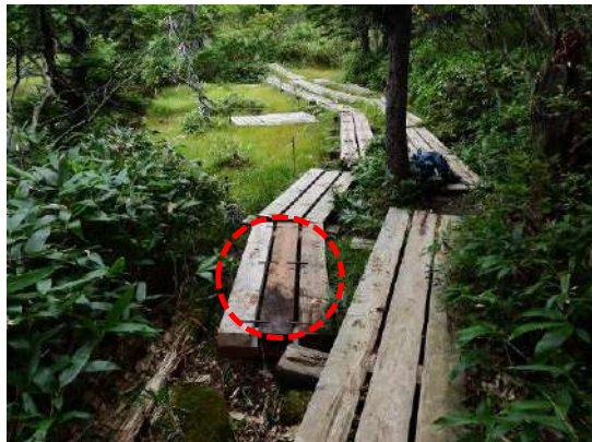
泥濘箇所への木道の追加設置
