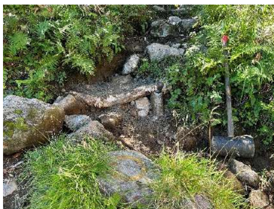
木柵と石材による歩行路の設置、段差処理
