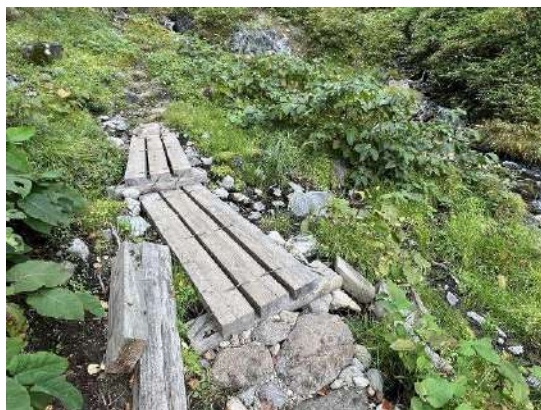
傾いた木道の撤去と新規木道の設置
