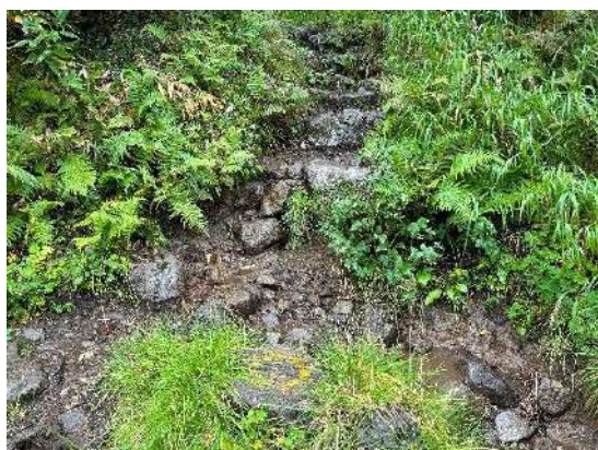
H・エゾ沼手前、路床保護と段差処理
