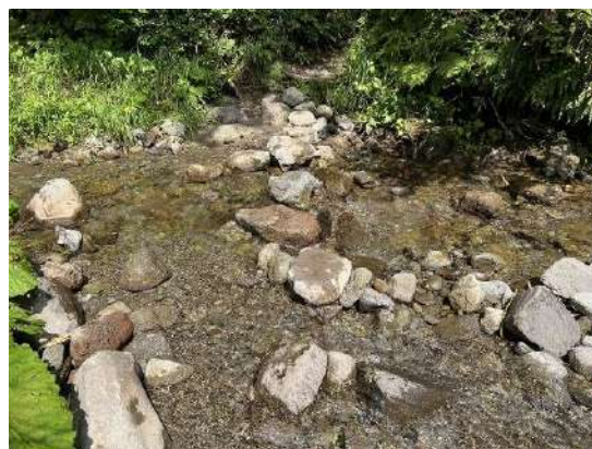
堆積した砂利の除去と飛び石の設置
