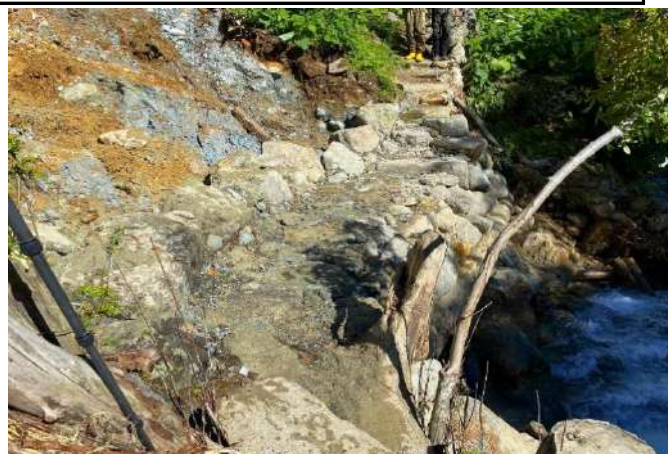
土砂崩れ斜面の土留め及び既存階段への段差処理
