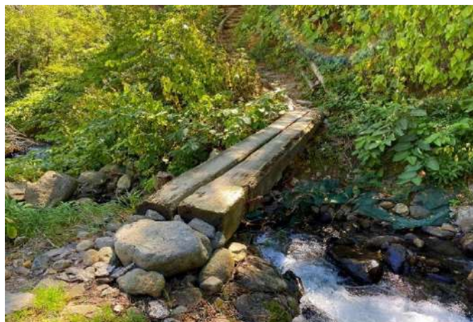
既存橋が一部折れていたなので交換(昔の橋を利用)
