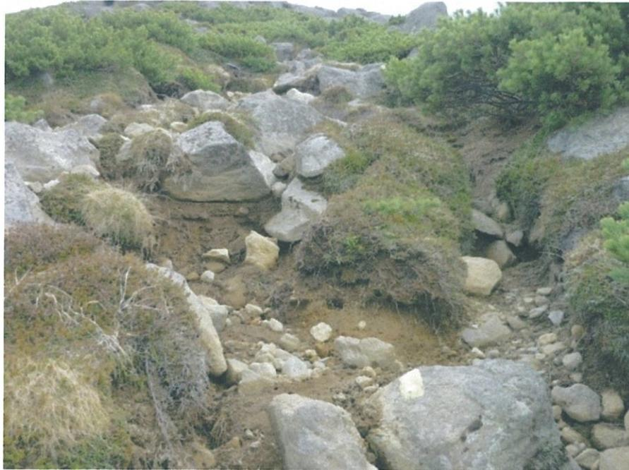
今回、補修を計画する区間の上部の状況。斜度が強く歩道も直線的に付いているため、雨水や雪解け水に加え登山者の踏圧による浸食・荒廃が進行している。
