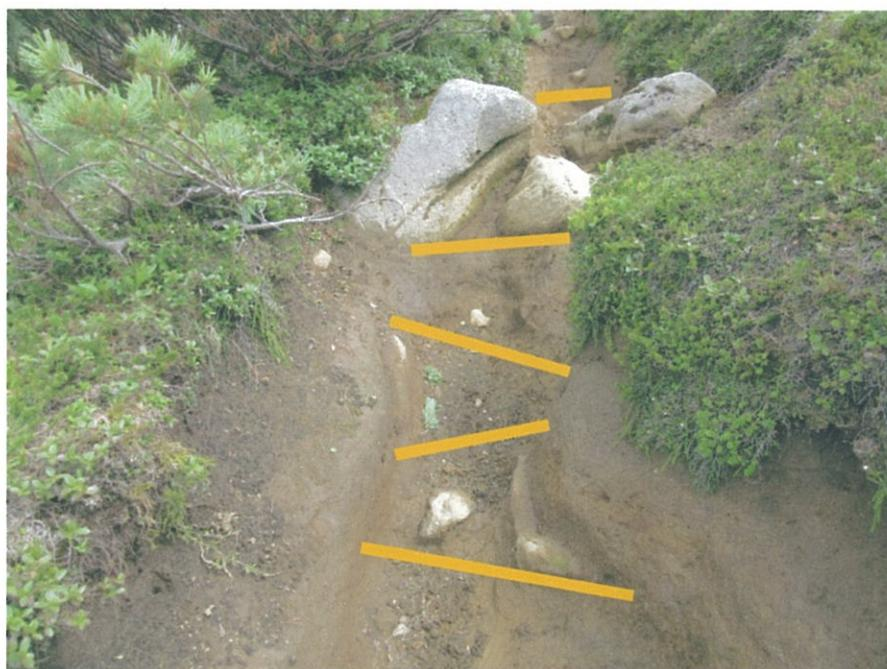
段差処理工と床止工で処理、角材のステップ上部には石材を詰める。
