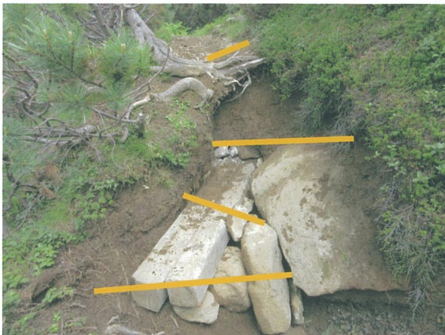
段差処理工と床止工で処理、角材のステップ上部には石材を詰める。最上部は分散排水工を設置し経過観察する。ハイマツの根の下の凹部は土嚢を積み浸食の防止を図る。
