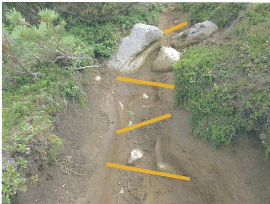
階段工と床止工で処理、角材のステップ上部には石材を詰める
