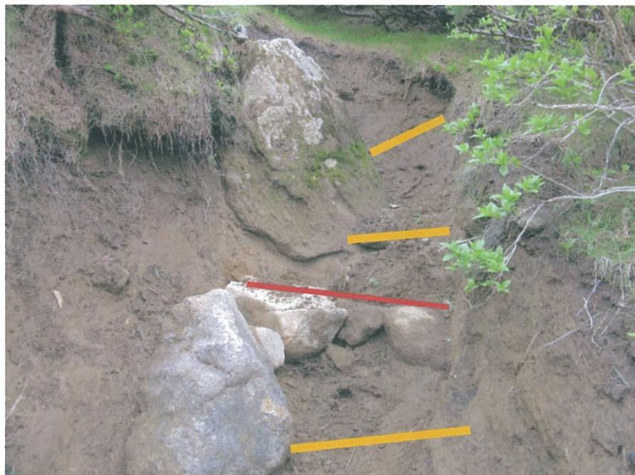
段差処理工と床止工で処理、角材のステップ上部には石材や土砂を詰める。
