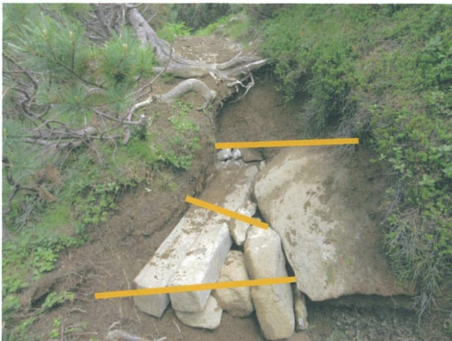
階段工と床止工で処理、角材のステップ上部には石材を詰める（写真角材は暫定処置）
