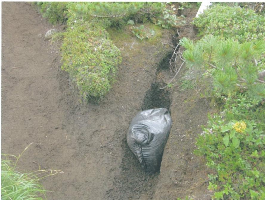
植物帯に流入した土砂を除去し収納した土嚢を水路化した旧歩道に仮置き。土嚢上部には土砂が堆積し、一定の効果が認められた。
