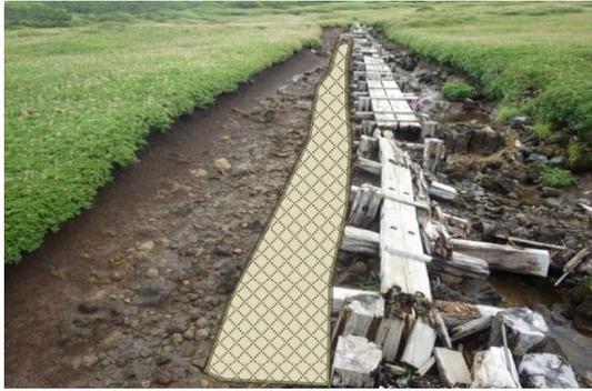
前年に行なったジオウェブでの床固め。礫の流出もなく、脇には土壤が溜まり、チングルマの芽吹きも見られる。表面に礫の追加を行なう予定。
