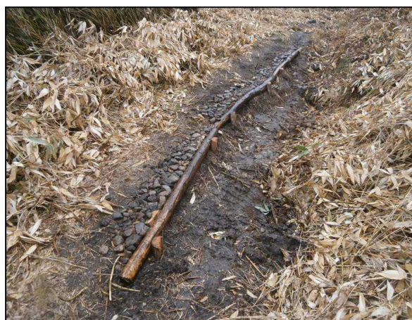
路肩を補強し歩行路を確保
