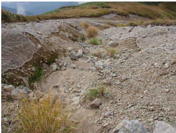
石組で土砂を安定させ黄麻製植生ネット敷設 (飯豊連峰・施工2年後)
