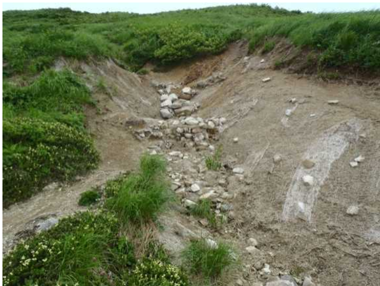
大規模な急斜面の裸地の植生回復状況
