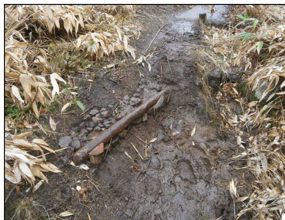
倒木と石でステップを設ける
