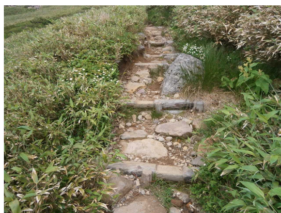
〔好例〕 搬入資材に現地資材を加え 調和した配置による公共工事の例 裾合平 (2006 年施工)
