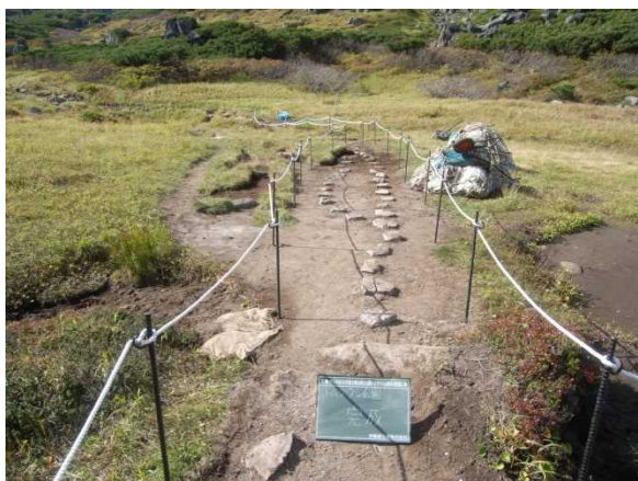
施工時 (2009 年度施工)
