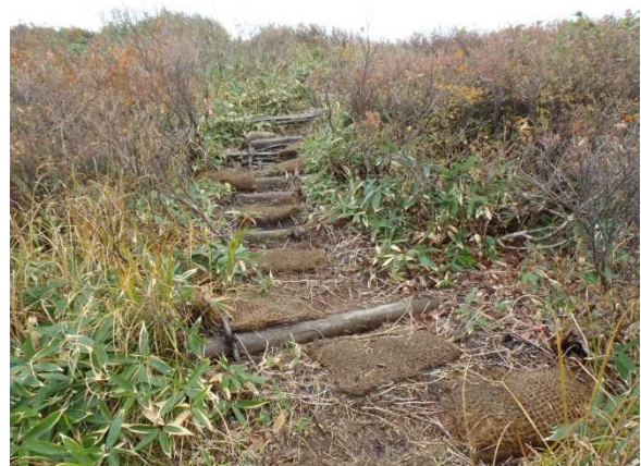
急勾配部には木柵土留を設置
