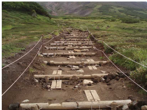
施工後 (2007 年度施工)
