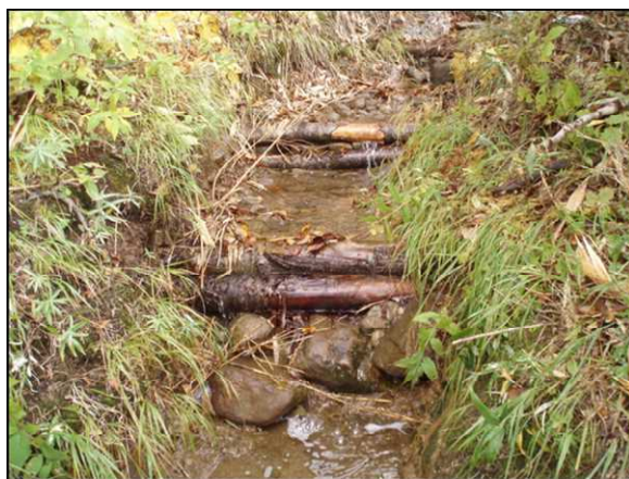
現地材によるステップ&プール工（木柵）
