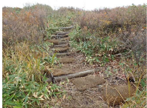
急勾配部には木柵土留を設置
