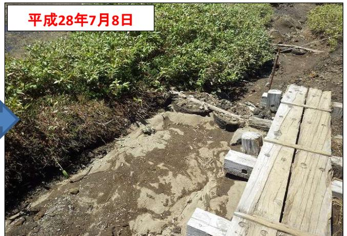
約2年で40cmほどの高さまで土砂が堆積している。
