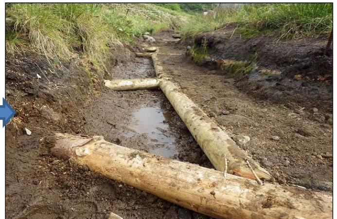
歩行路は路床よりも一段高くなるようにし、水の流があっても歩行路には流れないように設置。流水は低みを通れるが、3段の木柵土留めで流れが止まることにより土壌が侵食されにくくなる。
