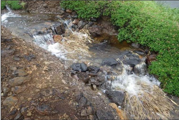
・流水がある場所での施工は、施工物を越流した水が落下したときにおこる洗掘現象を防ぐため、必ず水たたき処理を行なう。
