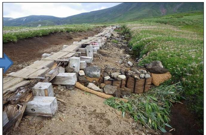
約10mの間に2基のテンサーによる土留め工を設置。
