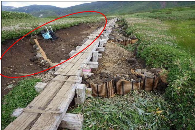
・流出している土壌は流水で削られたものだけでなく、法面からの凍結融解現象で侵食されているものも多いと想定される(赤丸部)。
