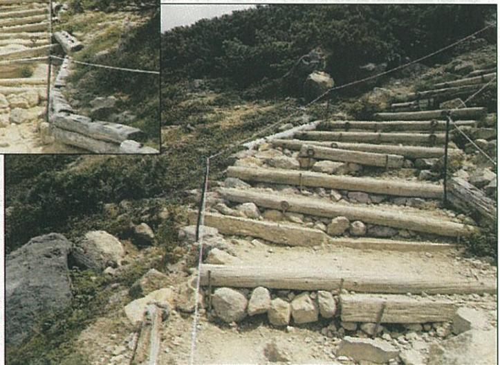
毎年簡易補修されているが、鉄ピンでの木材固定方法は変わらず、谷側の土壌流出防止のための石材はサイズが小さいので融雪に対応した補修にはなっていない。
