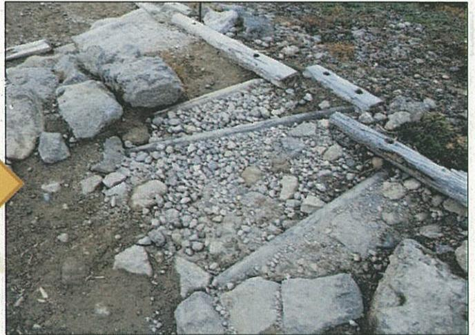
木材固定は大石への引掛け土中への埋め込み。杭よりも強度が期待できる。
