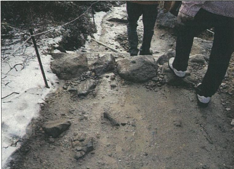
・組み換えの利点は、石材が大きく平滑な面もあるので、正しく施工できると恒久的に使える段差になること。
