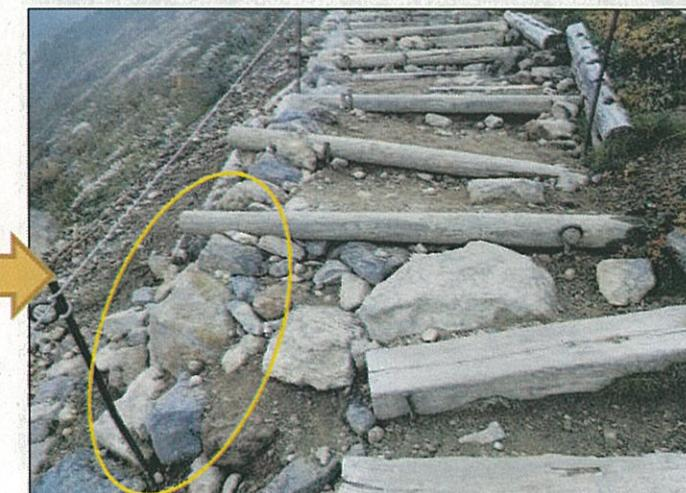
木柵の固定は鉄ピンに頼らず、谷側に設置した大石を起点に積み上げた石材で固定されるように配置した。
