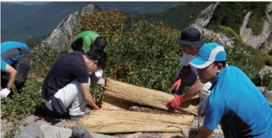
大高山頂維護作業（邊坡整治）
