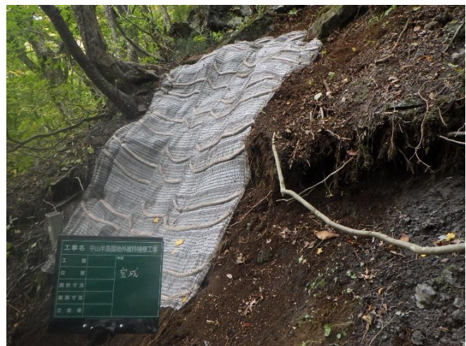
（R7に実施した法面保護工 ▲ ）
