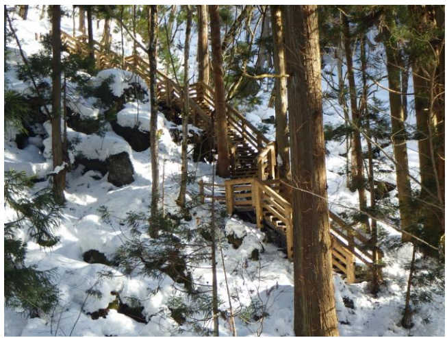
（R6に整備した階段工 ▲）
