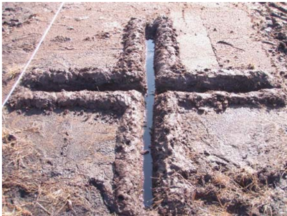
幅約 20cm、深さ 20cm または 10cm で掘削。掘削した土は両脇に土手状に盛土した。
