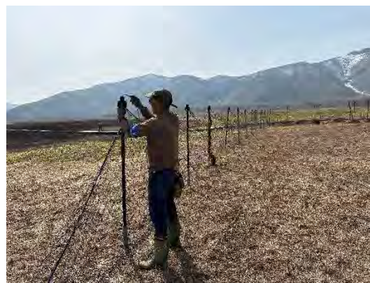
5月23日 張りロープの調整作業
