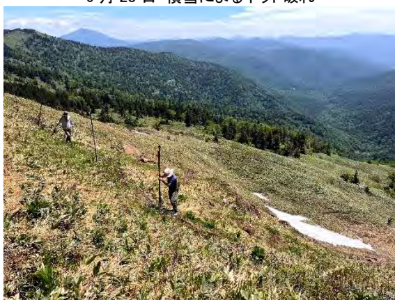
6月28日 支柱設置作業
