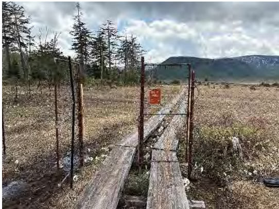
5月30日 木道部の扉設置完了
