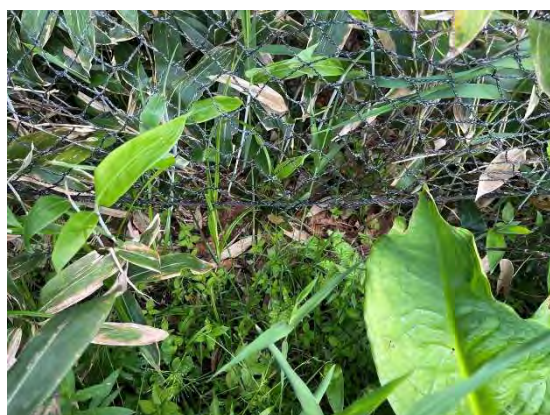
7月2日 アンカー杭抜け(点検番号1)
