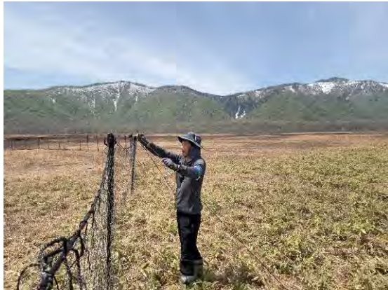
5月23日 張りロープの調整作業
