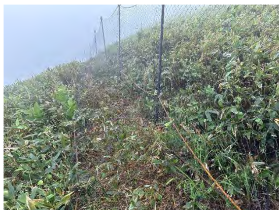
7月17日 スカートネットの増設
