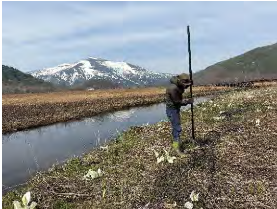
5月23日 支柱の設置作業
