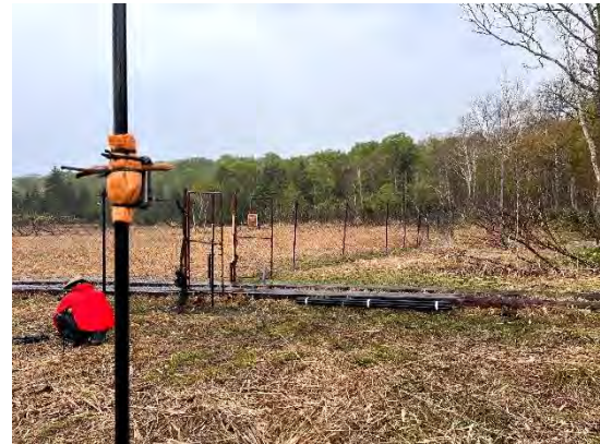
5月30日 木道部の扉とシカ侵入監視カメラ
