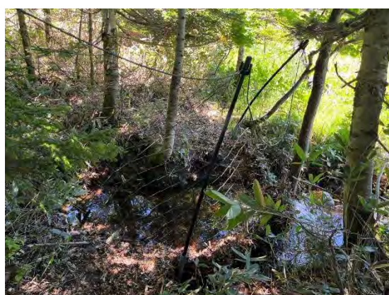
6月17日 支柱曲がり(点検番号1)
