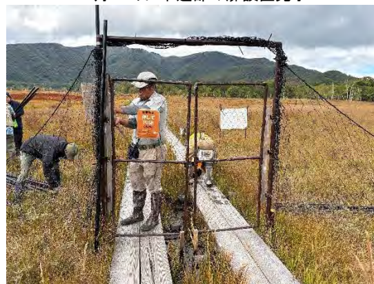
9月30日 木道部の扉の撤去
