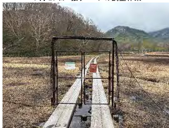
5月23日 木道部の扉設置完了
