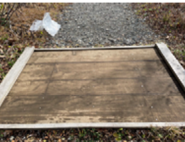
② 土砂回収後
