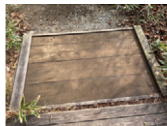
① 土砂回収後
