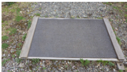
① マット設置
