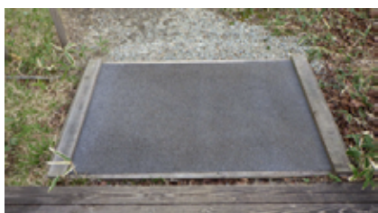
② マット設置
