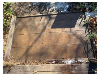
② 土砂回収後
