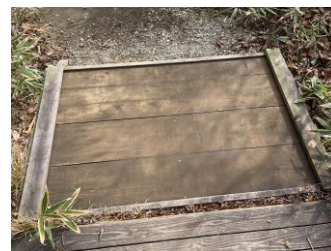
① 土砂回収後
