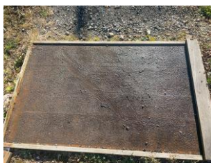
① 土砂堆積の様子
