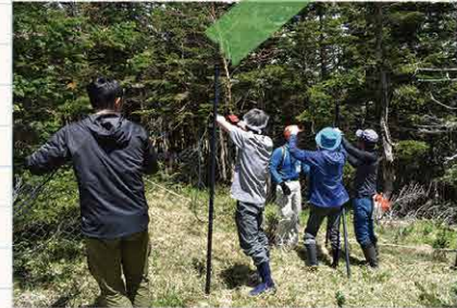
柵を設置している様子
