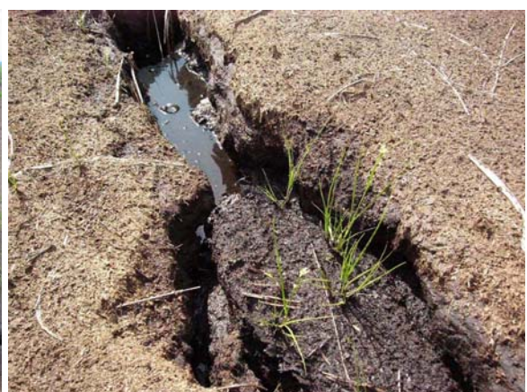
写真 10.2.8 亀裂にそって分布する植物。植物が生えている箇所は湿っている。
