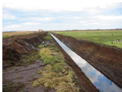
図 8.5.2 北海道開発局による工事中の緩衝帯の様子
