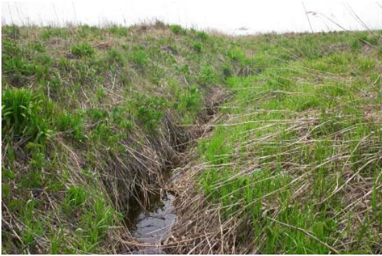
写真 7.2.1 水抜き水路①
