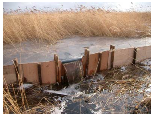
堰上げ 2 日後の状況 下流側の水路も堰上げ済み (融雪等の影響で相当量の越流が生じている)
