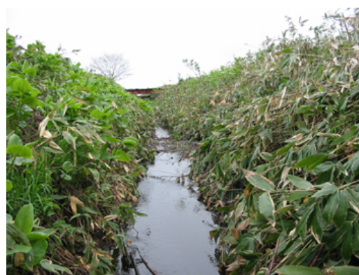
図 3.1.17 側溝内 (サロベツ川合流付近)
