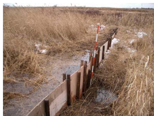
落合沼流出部 堰上げ直後の状況 (堰の延長は 10.5m、水路底から約 1.1m 堰上げ)
