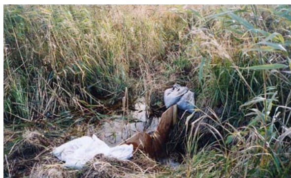
図 7.3.4 水抜き水路仮堰上げ調査の状況
