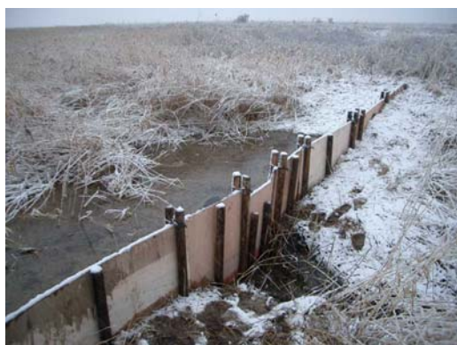
堰上げ翌朝の状況 (すでに堰天端近くまで湛水が見られる)
