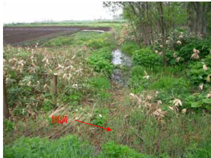
写真 6.2.3 地点Bの状況 農地脇の排水明渠が側溝に接続されている
