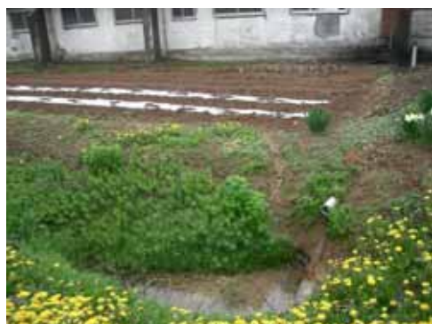
写真 6.20.1 地点 D の状況 牛舎から側溝に塩ビ管が敷設されている
