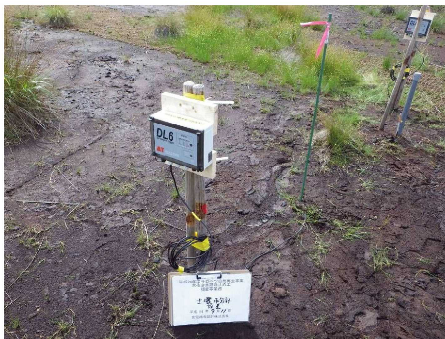
写真 V. 6.1 土壌水分計の設置状況
