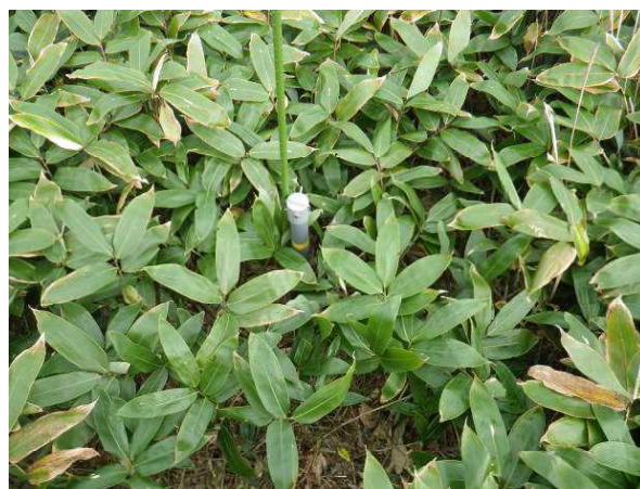
写真 V. 4. 2 水位計の設置状況
