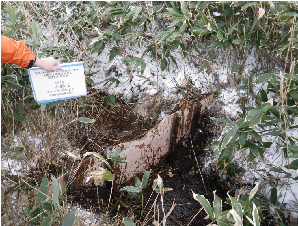
写真Ⅱ. 6. 9 水抜き水路5の仮堰上げ実施状況
