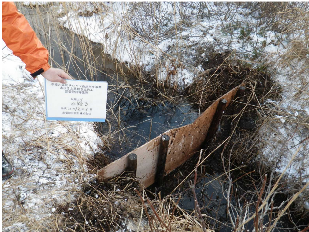
写真Ⅱ.6.6 水抜き水路3の仮堰上げ実施状況
