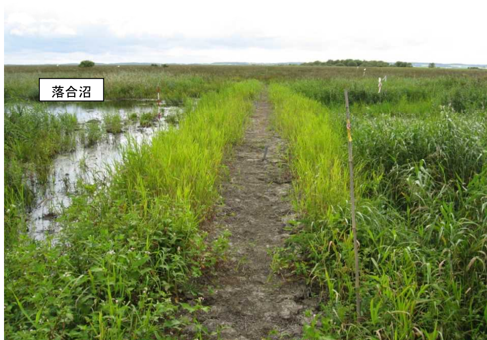
写真Ⅲ. 6. 12 落合沼堰き止め工堰堤（2010/8）
