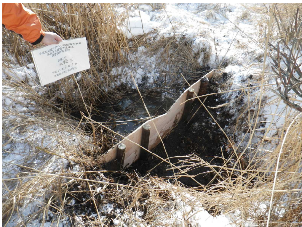
写真Ⅱ.6.8 水抜き水路4の仮堰上げ実施状況
