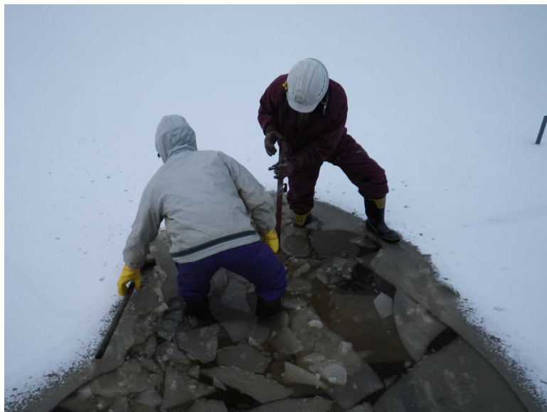
写真Ⅳ. 4. 3 標柱設置作業状況
