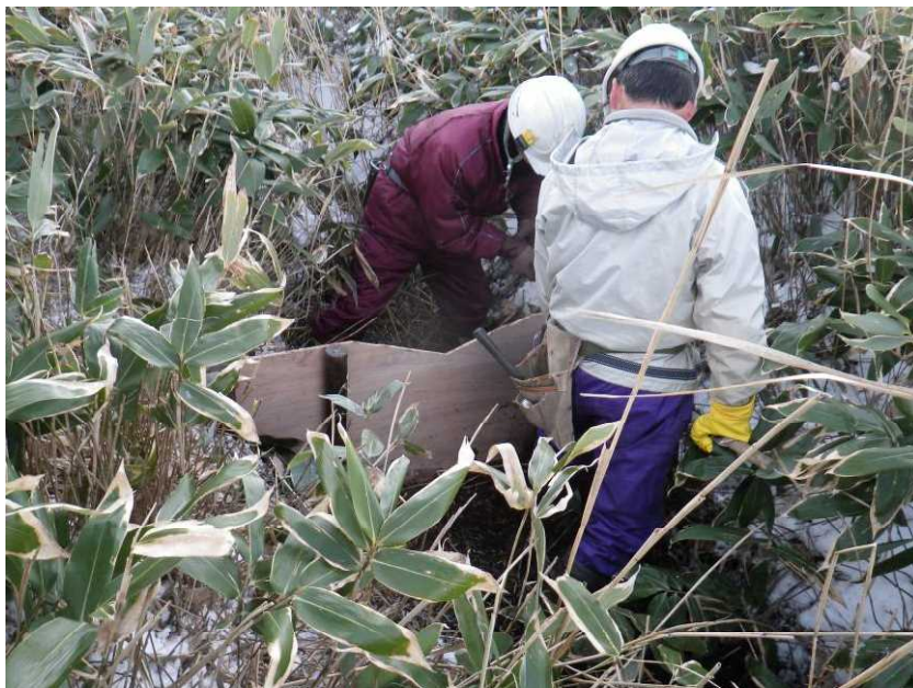
写真Ⅱ.4.6 仮堰設置作業
