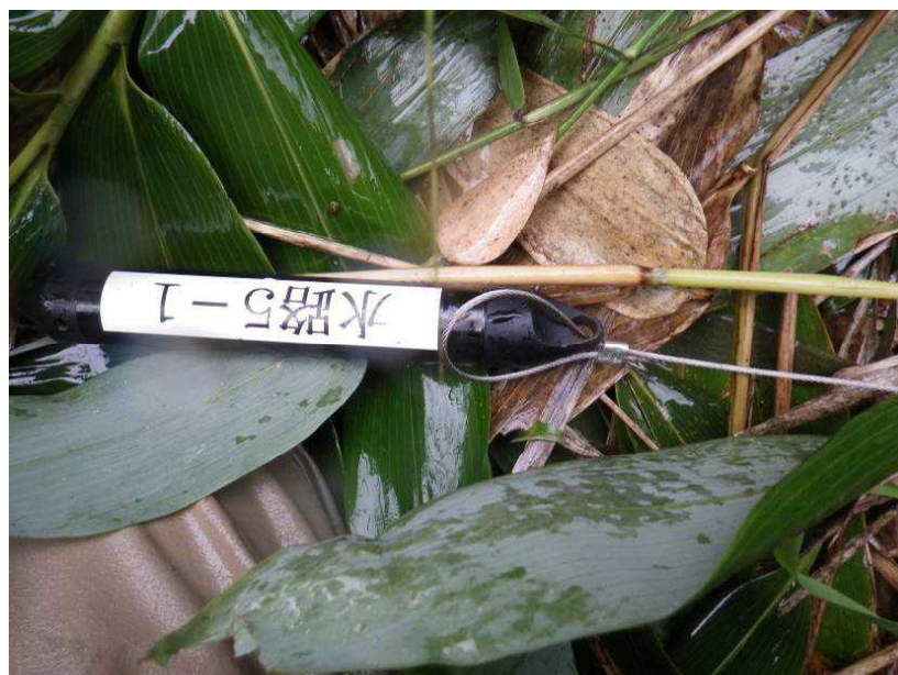
写真Ⅱ.4.8 地下水位計の設置
