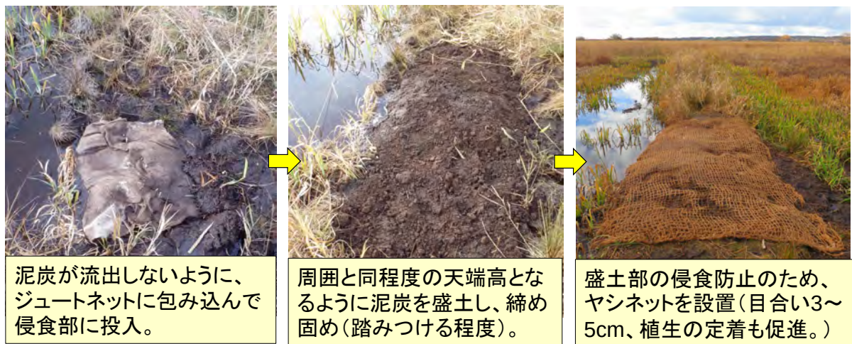
図 6-9 旧河川跡堰き止め工 越流部の補修状況
