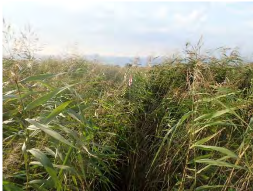
水抜き水路 4 埋戻し工
