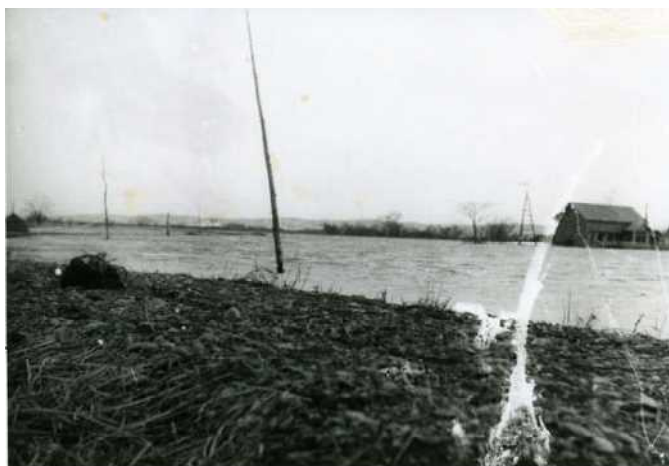
出水の様子(昭和 31 年)
