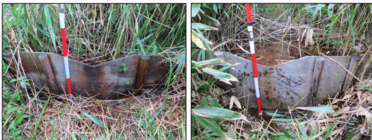
図 7.1.4 水抜き水路 4 (左) 及び水抜き水路 5 (右) における仮堰の状況
