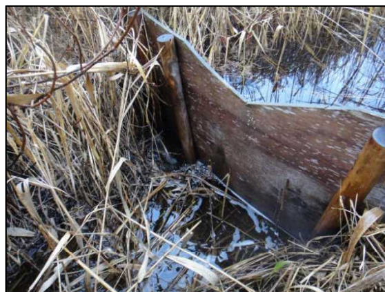
図 7.1.3 水抜き水路 3 に設置された仮堰
